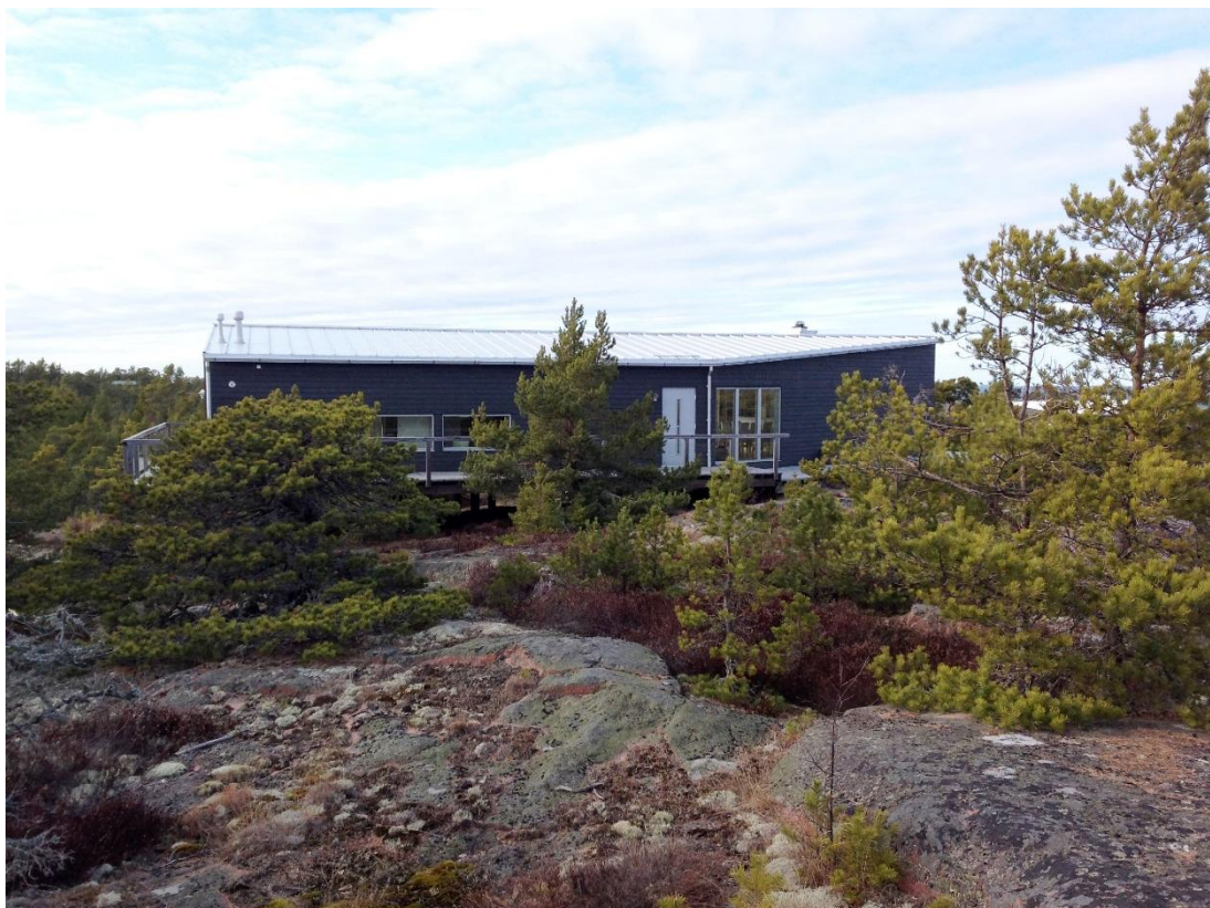
Figur 4 Friliggande klipphus, Thomas Sandell 2008 (Foto: E. Pinto-Guillaume/WSP - W170328_26.JPG).
